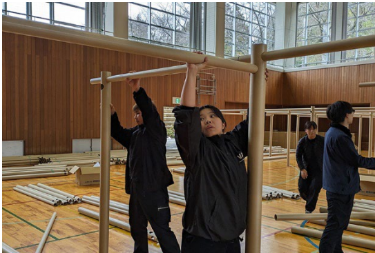
(写真左) 金沢市 1月9日に避難所に紙の間仕切り（ペーパーパーティションシステム）を設営
